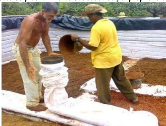
Figura 2 – Processo de preenchimento dos sacos de polipropileno com solo argiloso.
