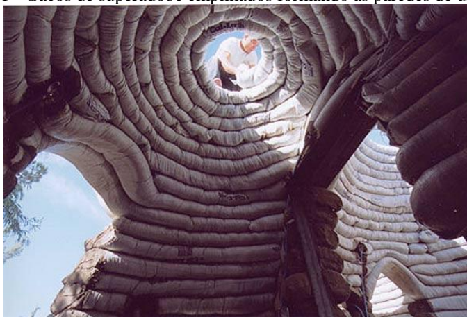
Figura 1 – Sacos de superadobe empilhados formando as paredes de uma casa.
